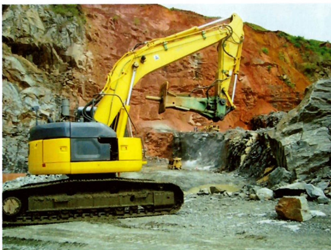
Figura 18 - Escavadeira com martelete hidráulico no local de trabalho
